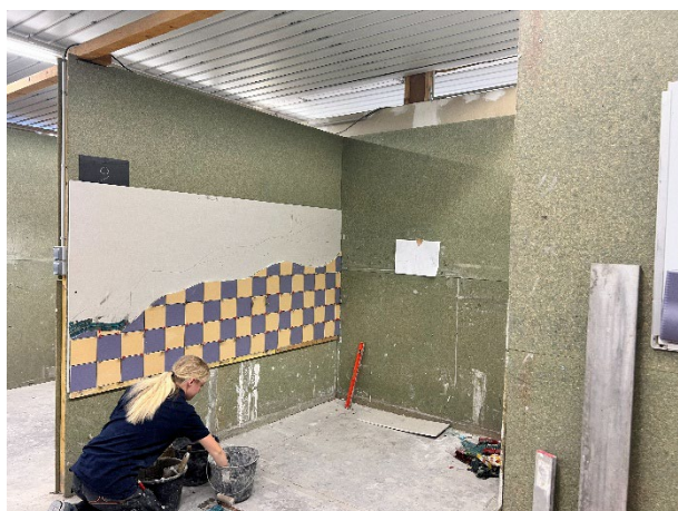
Chantier pédagogique des Compagnons du Devoir à Villeneuve d'Ascq
