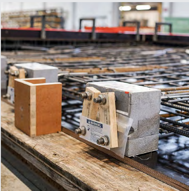
Isokorb® XT SK préintégré en usine dans les dalles de balcon pour une mise en œuvre optimisée.
