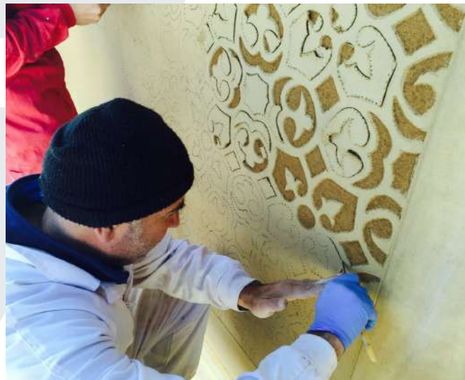
Mise en œuvre d'un moucharabieh avec la technique traditionnelle d'application.
