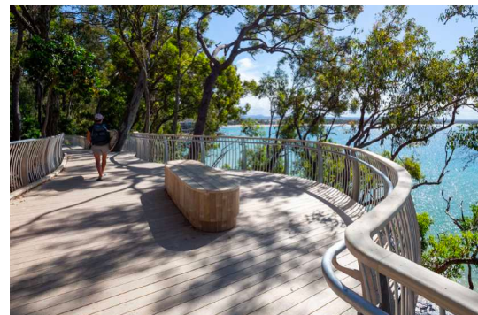
Promenade conçue en lames ACCOYA avec systèmes de fixations invisibles.
