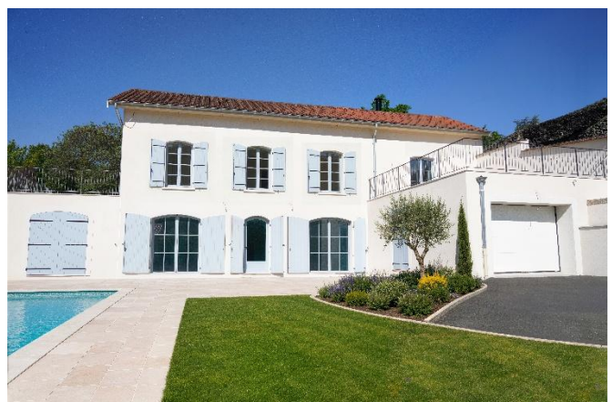
Chantier à Sainte-Foy-Lès-Lyon (69202), rénovation d'une ancienne maison de 590 m 2 avec utilisation du sous-enduit PAR HÉRITAGE SE et l'enduit de finition CALCIDÉCO.
