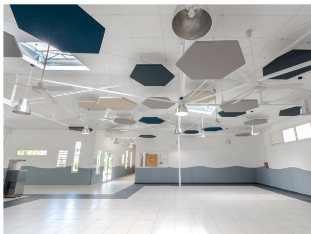
Ecole élémentaire CP/CE Rockfon Ekla® et Rockfon Eclipse®
