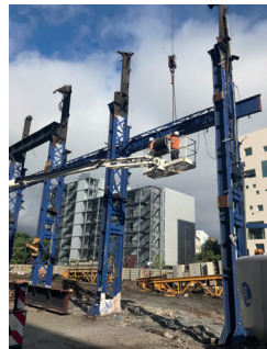
Exemple du démontage de poteaux acier sur un site Alstom et de leur ré-emploi sur le site industriel du Groupe Briand.
