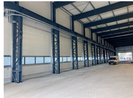
Exemple du démontage de poteaux acier sur un site Alstom et de leur ré-emploi sur le site industriel du Groupe Briand.
