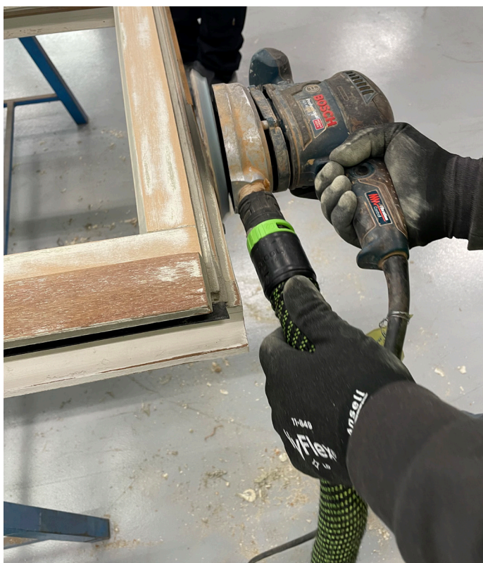
© Lorillard - Restauration d'une menuiserie
