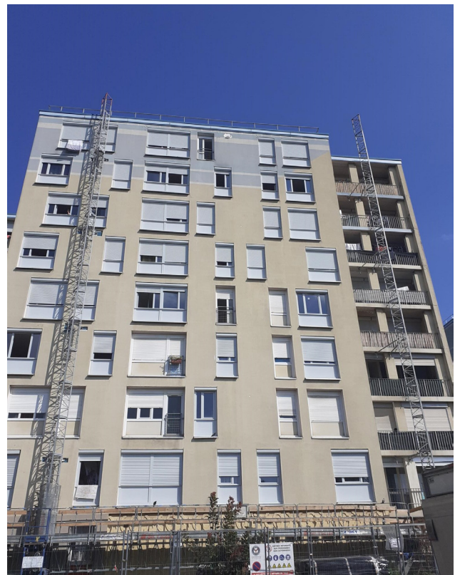
Façade durant la pose. ©Lorillard
