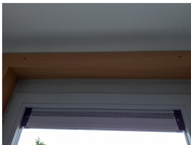
La menuiserie est dotée d'une grille d'aération de marque RENSON, condamnable via un levier, permettant d'occulter et d'étancher avec facilité et rapidité la pièce de confinement. ©Lorillard
