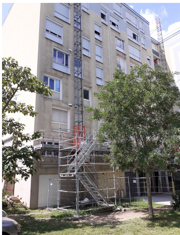
Façade durant la pose avec la plateforme bi-mât. ©Lorillard
