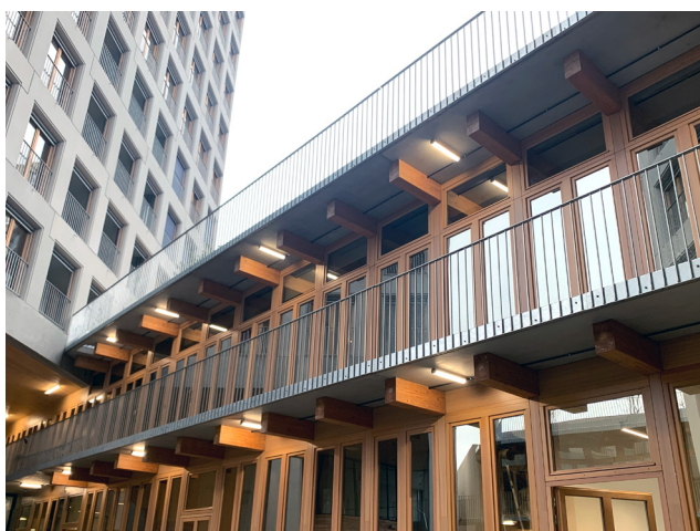
Les châssis bois (gamme Rennes) en Mélèze, aux dimensions hors normes pour les baies du SOHO © Lorillard
