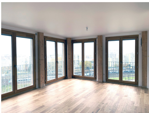
Menuiseries bois de la tour H1 dotées d'un vitrage phonique de 40 dB © Lorillard
