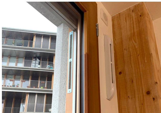
Silencieux Haut de Fenêtre posé en partie haute de la menuiserie, avant la pose du doublage. © Lorillard
