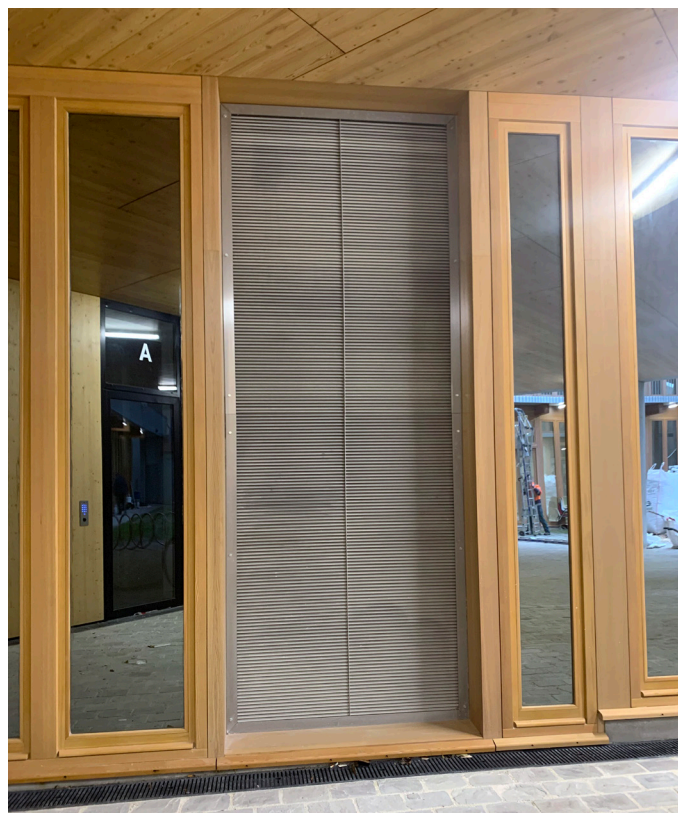
Vitrage anti-effraction SP 10 combiné à un tain réfléchissant du SOHO © Lorillard
