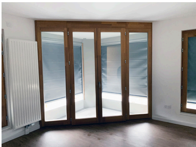
Porte-fenêtre avec stores extérieurs manœuvrés électriquement avec un guidage par coulisse pour une occultation totale. La toile est notamment dotée d'une couche bitumeuse pour une opacité maximale. © Lorillard
