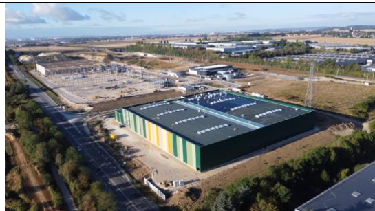
Vue aérienne récente du chantier
