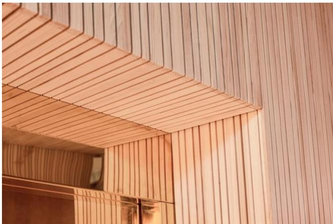
La surface du revêtement mural «made of LIGNO®» est classée comme «difficilement inflammable». Les panneaux sont fabriqués à cet effet en version spéciale de 40 mm d'épaisseur et la surface visible est imprégnée d'un produit ignifuge sans danger pour la santé.
