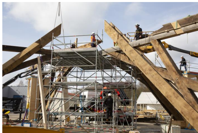
Visuel 6 : Levage à blanc des quatre pieds du tabouret de la flèche. © David Bordes / Etablissement public Rebâtir Notre-Dame de Paris.
