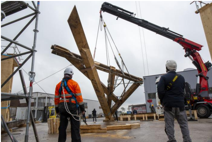
Visuel 1 : Levage à blanc d'un des pieds du tabouret de la flèche. © David Bordes / Etablissement public Rebâtir Notre-Dame de Paris.
