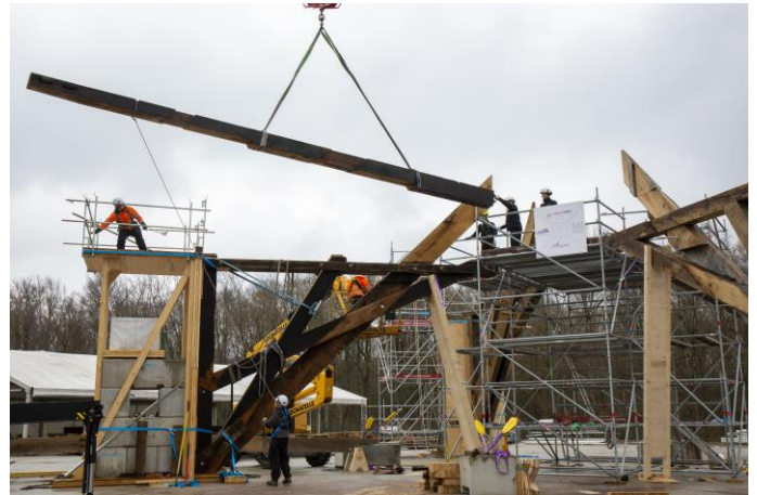
Visuel 2 : Levage à blanc d'un des trois niveaux d'une des deux poutres diagonales composées du tabouret. © David Bordes / Etablissement public Rebâtir Notre-Dame de Paris.
