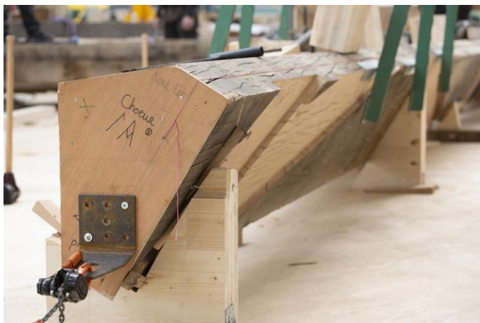
Visuel 5 : Vue par bout d'une des jambes de force pentagonales du tabouret. © David Bordes / Etablissement public Rebâtir Notre-Dame de Paris.
