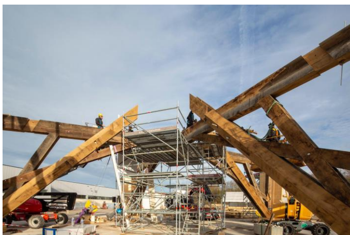
Visuel 7 : Levage à blanc des quatre pieds du tabouret de la flèche. © David Bordes / Etablissement public Rebâtir Notre-Dame de Paris.
