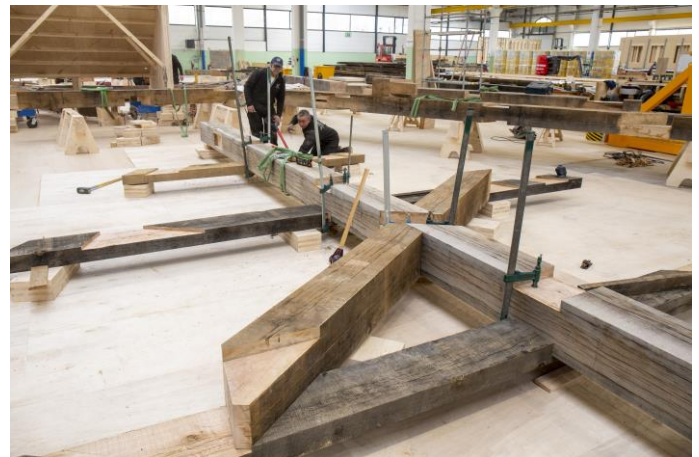
Visuel 4 : Préparation d'une ferme périphérique de la flèche. © David Bordes / Etablissement public Rebâtir Notre-Dame de Paris.
