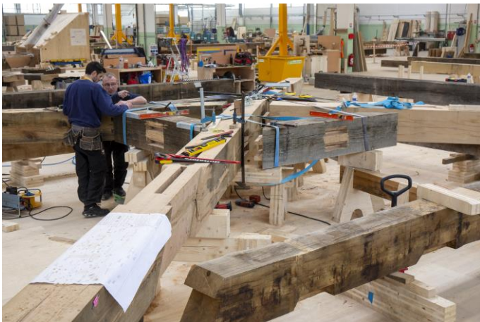
Visuel 3 : Mise dedans des poutres diagonales et des goussets du tabouret. © David Bordes / Etablissement public Rebâtir Notre-Dame de Paris.
