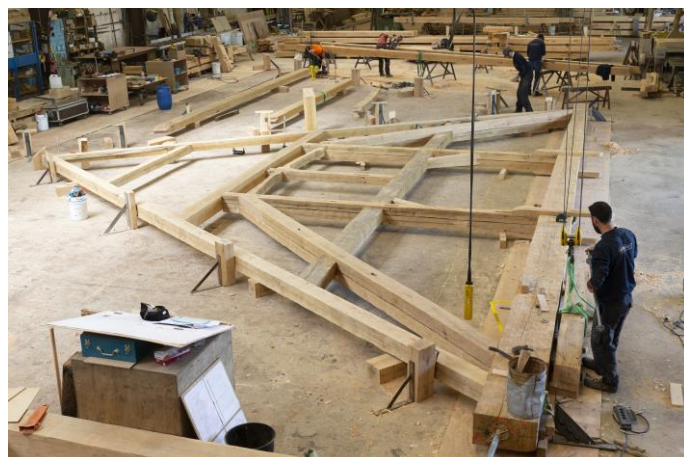
Visuel 4 : Une des fermes principales de la charpente du chœur assemblée, avant levage. David Bordes © Rebâtir Notre-Dame de Paris.
