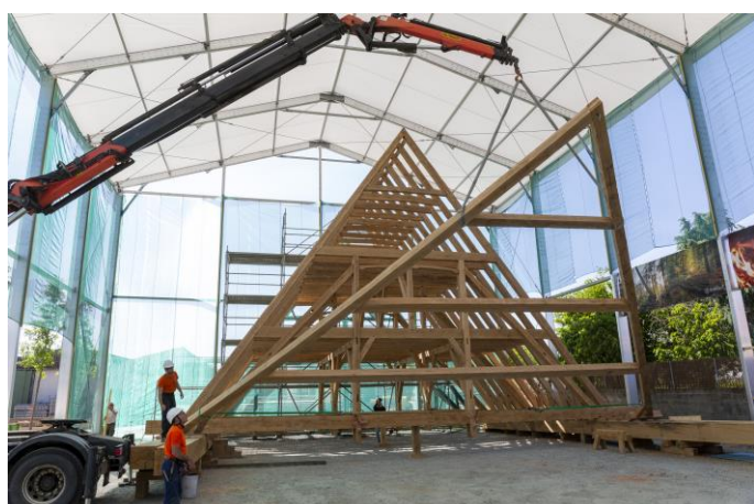
Visuel 7 : Levage à blanc d'une ferme de la charpente du chœur. David Bordes © Rebâtir Notre-Dame de Paris.
