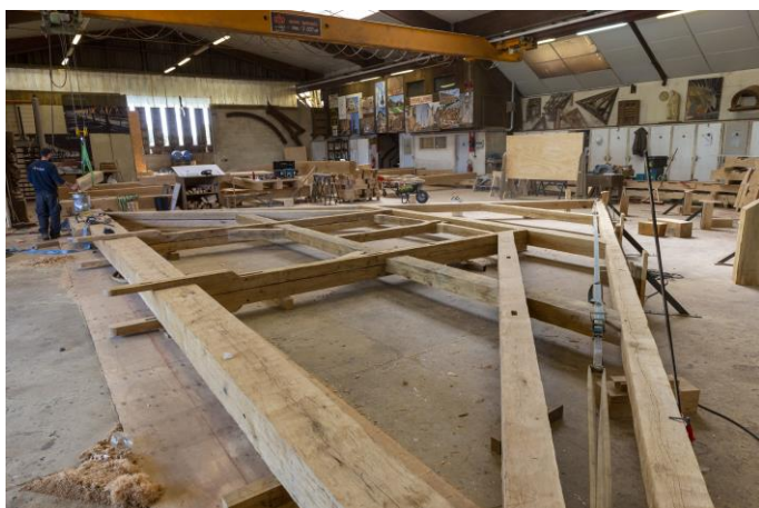
Visuel 3 : Une des fermes principales de la charpente du chœur assemblée, avant levage. David Bordes © Rebâtir Notre-Dame de Paris.
