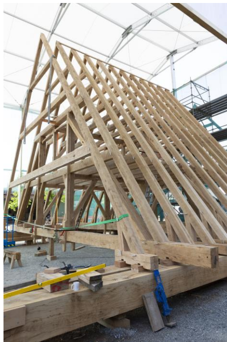
Visuel 11 : Deux des six travées de la charpente du chœur montées à blanc. David Bordes © Rebâtir Notre-Dame de Paris.
