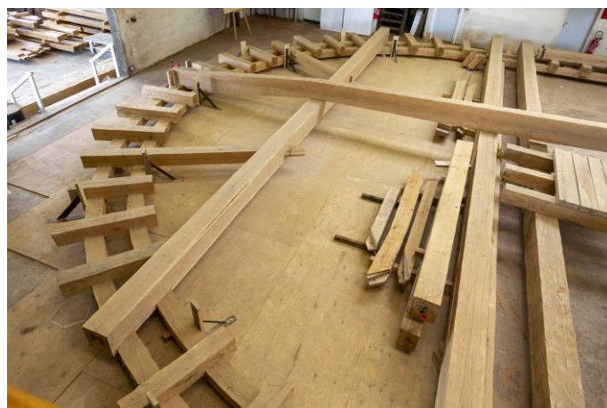
Visuel 6 : Charpente de l'abside du chœur en cours d'assemblage. David Bordes © Rebâtir Notre-Dame de Paris.
