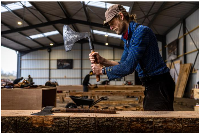
Visuel 1 : Equarrissage manuel de la charpente du chœur. © Franck Gallen – Pix Machine
