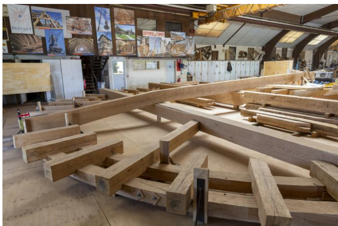
Visuel 5 : Charpente de l'abside du chœur en cours d'assemblage. David Bordes © Rebâtir Notre-Dame de Paris.
