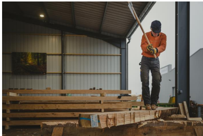
Visuel 2 : Equarrissage manuel de la charpente du chœur. © Franck Gallen – Pix Machine
