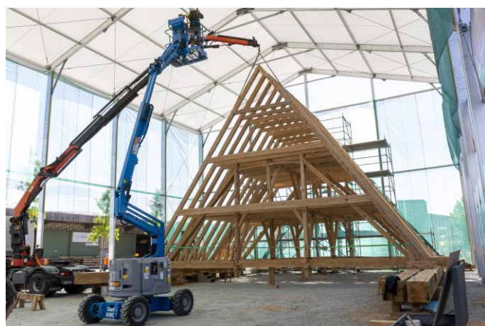
Visuel 8 : Levage à blanc d'une ferme de la charpente du chœur. David Bordes © Rebâtir Notre-Dame de Paris.
