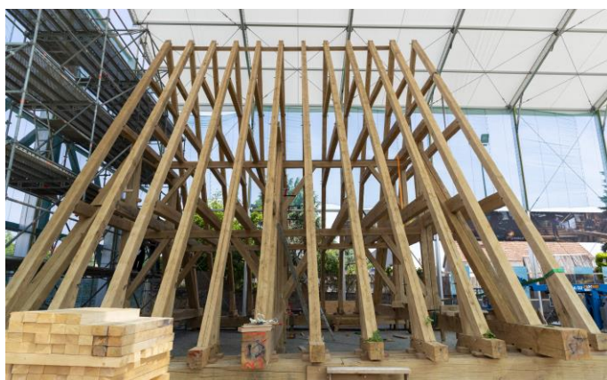
Visuel 9 : Deux des six travées de la charpente du chœur montées à blanc. David Bordes © Rebâtir Notre-Dame de Paris.
