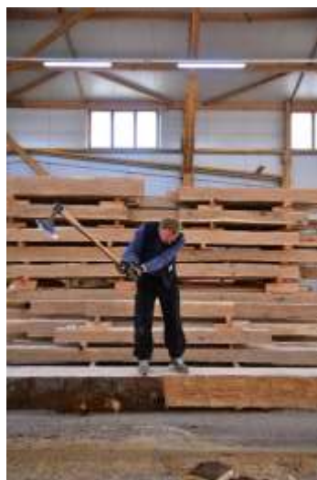
Visuel 2 : Equarrissage manuel de la charpente de la nef. © Guillaume Tampier © Ateliers Desmonts
