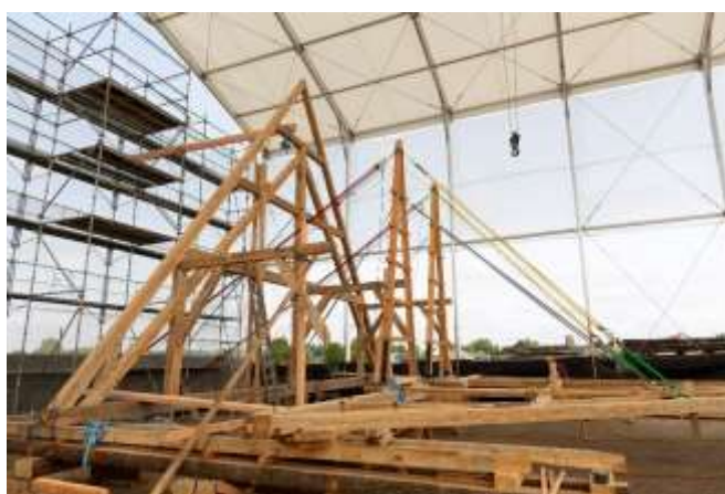
Visuel 7 : Préparation du levage manuel à blanc d'une ferme de la charpente de la nef. David Bordes © Rebâtir Notre-Dame de Paris.
