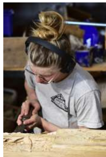
Visuel 3 : Taille manuelle de la charpente de la nef. © Guillaume Tampier © Ateliers Desmonts
