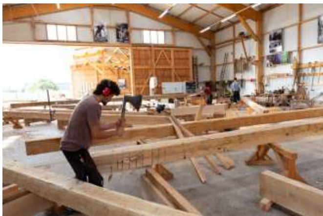
Visuel 4 : Equarrissage manuel de la charpente de la nef. David Bordes © Rebâtir Notre-Dame de Paris.
