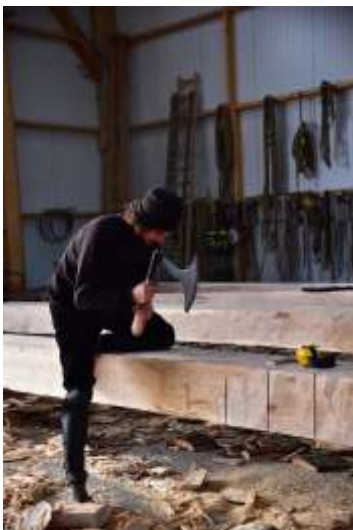
Visuel 1 : Equarrissage manuel de la charpente de la nef. © Guillaume Tampier © Ateliers Desmonts
