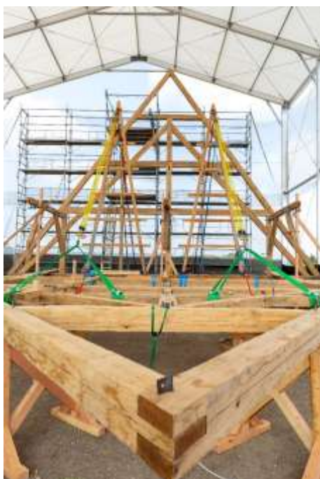
Visuel 6 : Préparation du levage manuel à blanc d'une ferme de la charpente de la nef. David Bordes © Rebâtir Notre-Dame de Paris.
