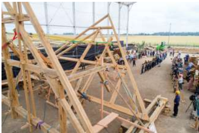
Visuel 9 : Levage manuel à blanc d'une des fermes de la charpente de la nef. David Bordes © Rebâtir Notre-Dame de Paris.
