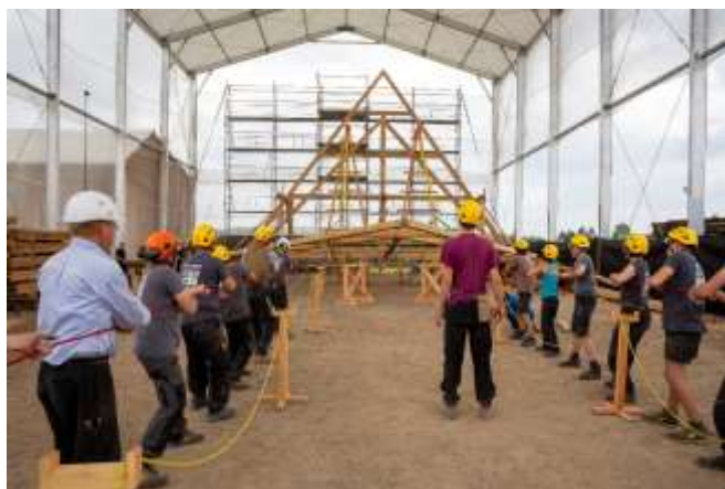
Visuel 8 : Levage manuel à blanc d'une des fermes de la charpente de la nef. David Bordes © Rebâtir Notre-Dame de Paris.
