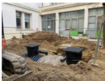
De plus, sa **modularité** permet d'ajuster les capacités de stockage et d'infiltration en fonction des besoins spécifiques du chantier. Par ailleurs, **sa résistance aux charges roulantes** lui permet d'être installée sous les voies d'accès sans compromettre leur fonctionnalité, préservant ainsi les espaces verts environnants.
