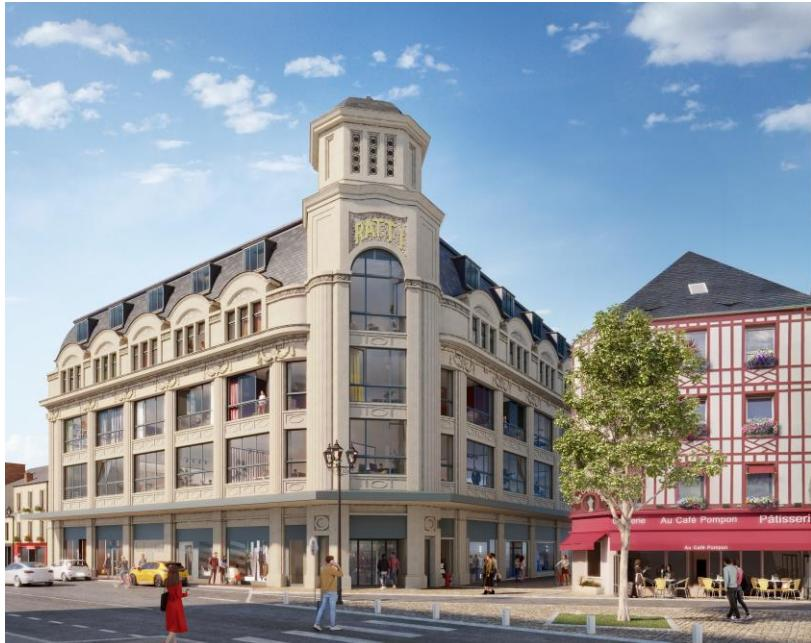
d'origine. Pour améliorer les performances thermiques, toutes les baies seront remplacées et fermées par des châssis intérieurs étanches et isolants. Les baies de la façade sur rue obstruées dans les années 1970 seront rouvertes et équipées de menuiseries en bois à double vitrage reproduisant le dessin d'origine.
