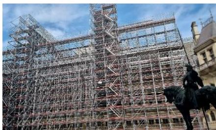
Réalisée par la filiale échafaudage Service, l'installation de ce monumental échafaudage parapluie Layher, et l'ensemble des installations de chantier qui l'accompagnent constituent à proprement parler d'un « chantier dans le chantier », destiné à faciliter le travail des restaurateurs et à leur assurer la mise à disposition de moyens d'accès, sûrs, pratiques et ergonomiques. Au total, sur 4 mois, ce ne sont pas moins de 700 tonnes d'échafaudages installées par 24 monteurs.
