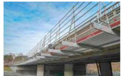
Adaptée pour s'installer en sous face d'ouvrage ou en franchissement, la poutre suspendue FLEXBEAM a été conçue également pour assurer un montage rapide, efficace et rentable.
