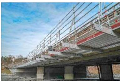
**FlexBeam:** La plateforme suspendue haute résistance pour rénovation rapide d'ouvrages d'art, FlexBeam, associe les performances de l'échafaudage Universel® de Layher à une poutre en aluminium nouvelle génération. Adaptée pour s'installer en sous face ou sur les côtés, la plateforme suspendue FlexBeam a été également conçue pour assurer un montage rapide, efficace et rentable.
