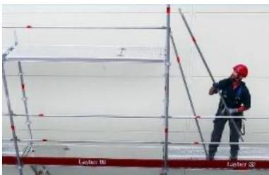
**UNI-SAFE** : Inédit sur le marché de l'échafaudage, le système UNI-SAFE se compose de montants comportant deux clips rouges permettant de relier très rapidement les éléments les uns aux autres. Ce système permet un montage en MDS (Montage et Démontage en Sécurité) des échafaudages en version Lightweight, composés d'un acier haute qualité. UNI-SAFE est une évolution de la gamme Universel®, gamme phare chez Layher, et est compatible avec tous les produits qui la composent.
