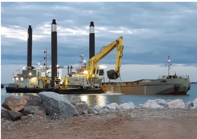
Construction de la digue
