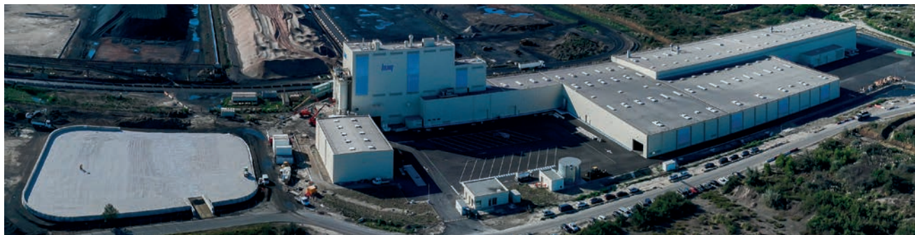
L'usine Knauf de Fos-sur-Mer
