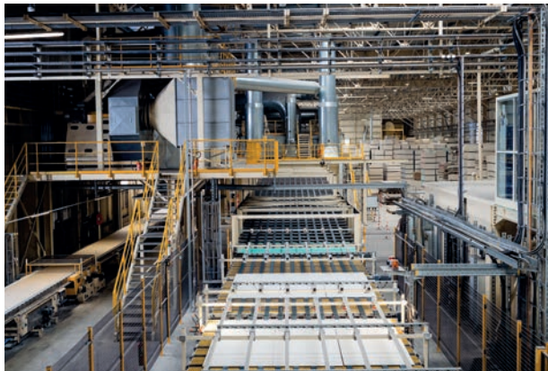
6. Sortie des plaques de plâtre Knauf du sécheur
