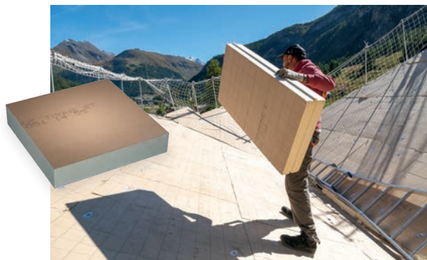
Isolation d'une toiture terrasse en polyuréthane, Knauf Thane
