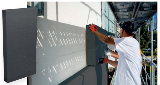
Mise en œuvre d'une isolation thermique par l'extérieur en polystyrène expansé bas carbone, NEXTherm®
