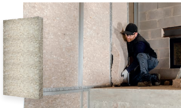
Mise en œuvre du ThermaSoft® natura, isolant intérieur biosourcé et recyclé
