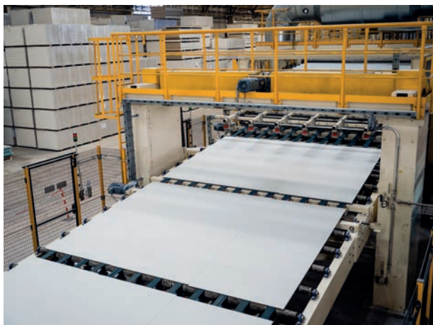
5. Entrée des plaques de plâtre Knauf dans le sécheur
