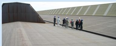
ArcelorMittal à Dunkerque
