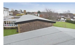
Toiture absorbante de CO 2
