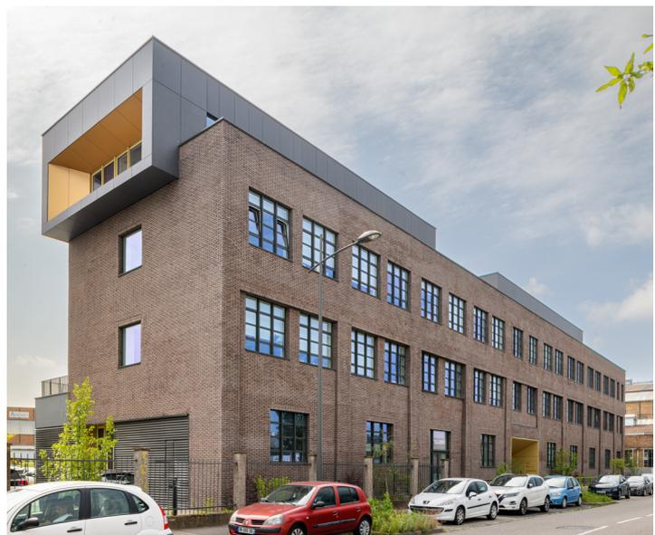
L'immeuble traversant de seulement 10 m de large bénéficie d'une hauteur sous plafond généreuse, d'une vue dégagée et d'une belle luminosité naturelle, grâce à de larges ouvertures qui ont été conservées. Après remplacement du support de toit au moyen d'un système bois/béton, l'ouvrage a été surélevé grâce à la pose de deux attiques en ossatures bois et habillées d'aluminium (surface : 240 m<sup>2</sup>).
