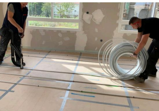
Des tubes Multicouches Pex-Al-Pex R999 de 16 mm ont été privilégiés garantissant l'imperméabilité qui limite l'entartrage et l'embouage.
