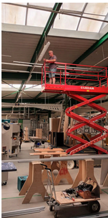
Pose des gaines textiles à XX m maximum. Conformément aux contraintes du bâtiment.
