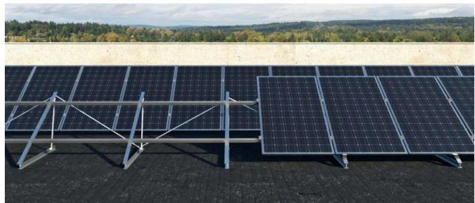
**Les systèmes en acier** et la grande variété de rails permettent de créer des structures pour fixer plusieurs rangées de panneaux avec des inclinaisons variables. Galvanisés à chaud ou en acier inoxydable, ces systèmes résistent aux intempéries et à la corrosion.
