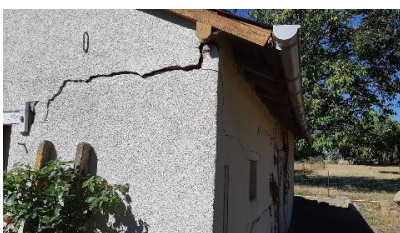
Maison fissurée par la sécheresse
