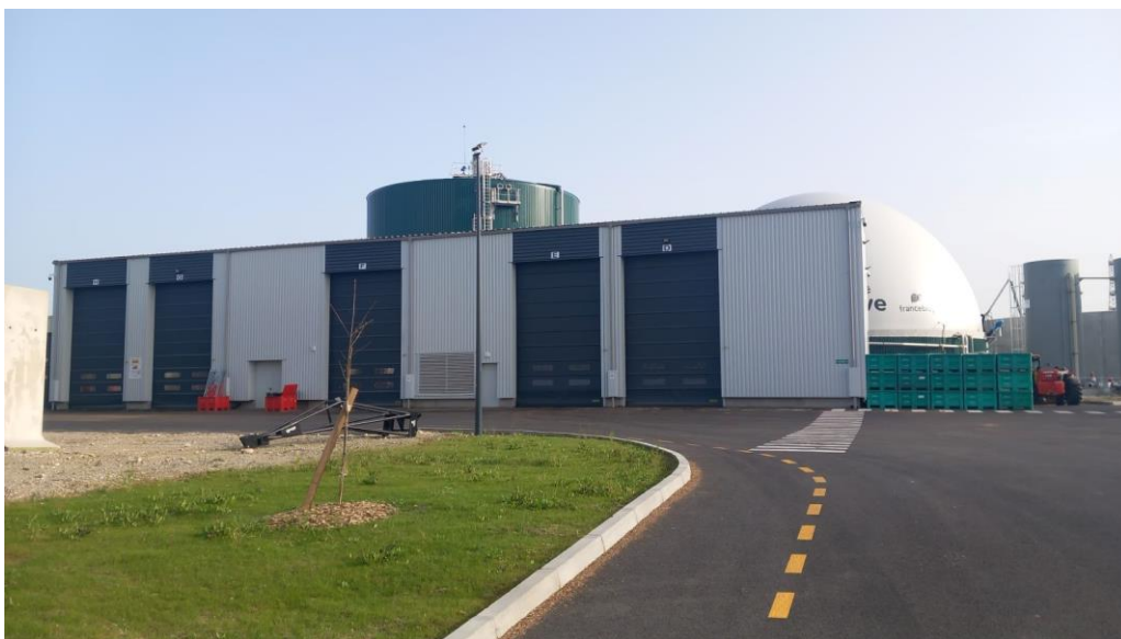
Bâtiment de réception des intrants
