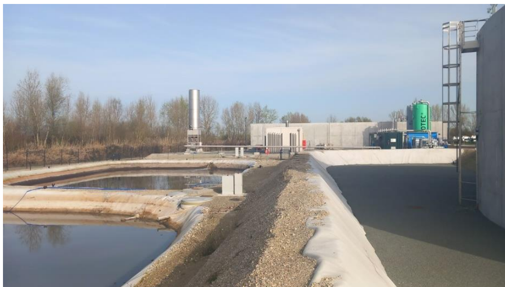
Bassins d'eaux pluviales
