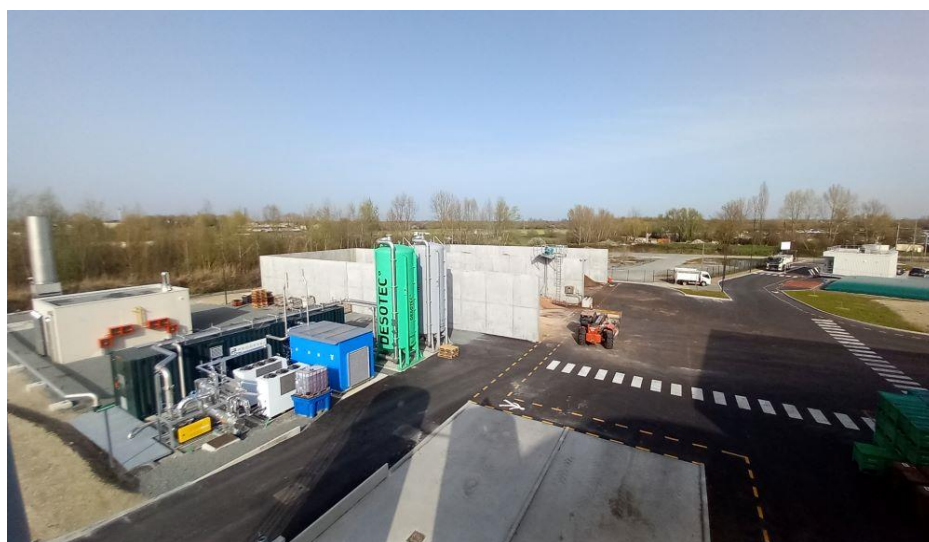
Unité d'épuration de biogaz / Silos de stockage
