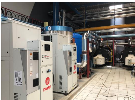
Thermofrigopompe installée en chaufferie
