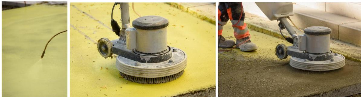
Les désactivants Pieri®VBA Flex sont biodégradables suivant la norme NF EN ISO 9408 et offrent des performances de cure conformes à la norme NF P18-371 et au référentiel de certification NF 085. Le pouvoir de cure après application permet la réalisation de béton désactivé conforme aux norme NF EN 13877 et NF P98-170 relatives à la réalisation de chaussée en béton sans action ni produits complémentaires.
