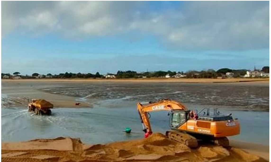
Extraction du sable du port de Saint-Denis de l'Île d'Oléron à l'aide d'une pelle sur chenilles CASE CX490D
