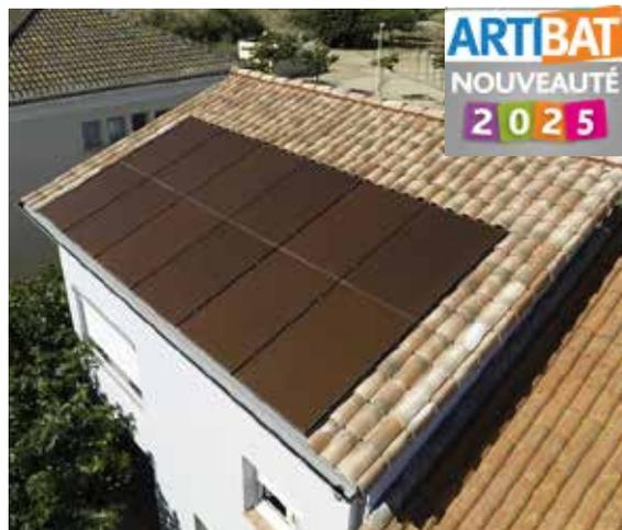
Grâce à de nouveaux abergements qui assurent une parfaite étanchéité du toit, inclus dans le kit EASY ROOF INTÉGRATION, ce système breveté de fixation est désormais sous ATEC validé par le CSTB pour tous types de couverture. L'EASY ROOF INTÉGRATION KIT est disponible sous ATEC avec des modules fullblack 445Wc JINKO ou des modules rouges 400Wc DAH SOLAR, pour les couvertures en :
