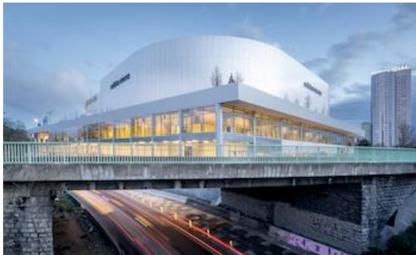
**L'ouvrage est une vitrine architecturale autant qu'un laboratoire environnemental :** 30% des bétons utilisés pour la construction sont issus de la filière bas carbone et sa façade est en aluminium recyclable.
