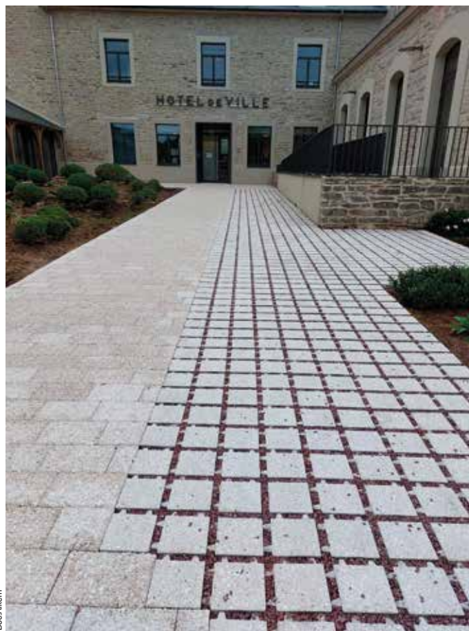
Les pavés Coquillage d'Alkern, au coefficient de perméabilité élevé, intègrent des coquilles Saint-Jacques (30 kg/m 2 ) en remplacement des granulats naturels non renouvelables, ici la nouvelle allée de l'Hôtel de Ville de Guichen (35).
