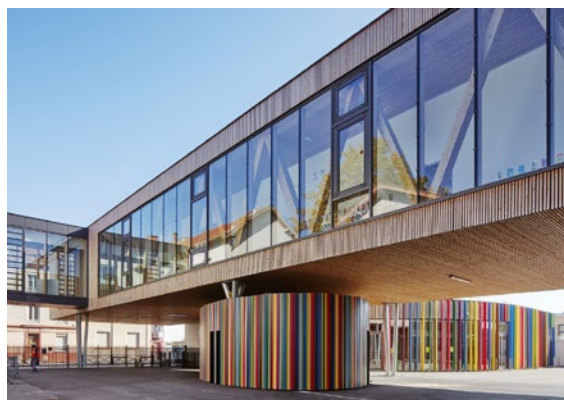
Groupe scolaire Berthelot, Villeurbanne (Rhône) Ossature bois, isolation thermique en ouate de cellulose et fibre de bois © Renaud Araud photographe – Tekhné / Lieux Fauves Architectes
