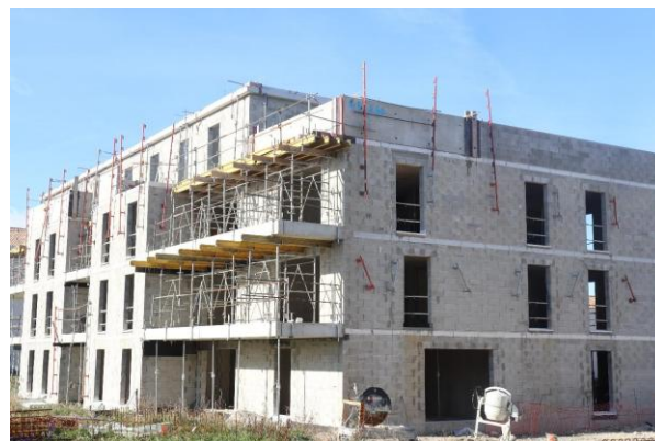
Chantier de 80 logements en Bloc AIRIUM type FABTHERM'AIR 1.1
