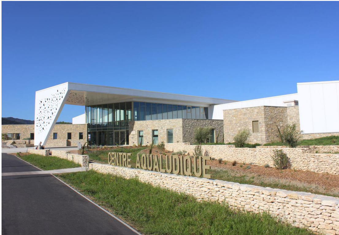
Le nouveau centre aqualudique de Manosque - Crédit Florent Joliot pour A26
