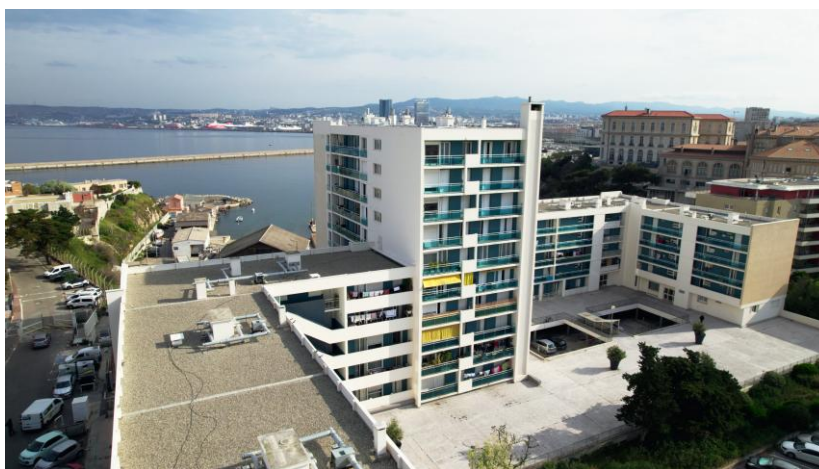
Résidence Le Pharo à Marseille (Crédit photo : Derbigum)
