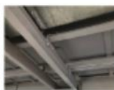
20,7 t de structure métal
