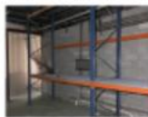
7,5 t de racks
