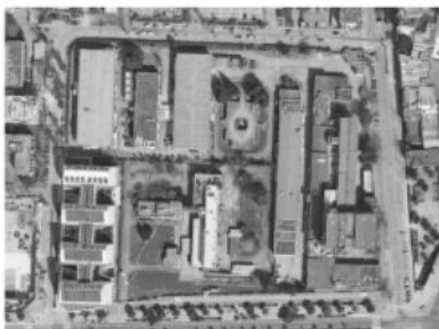
Démolition de laboratoires (Lyon)
