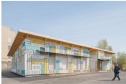
Maison du projet (Oullins)
