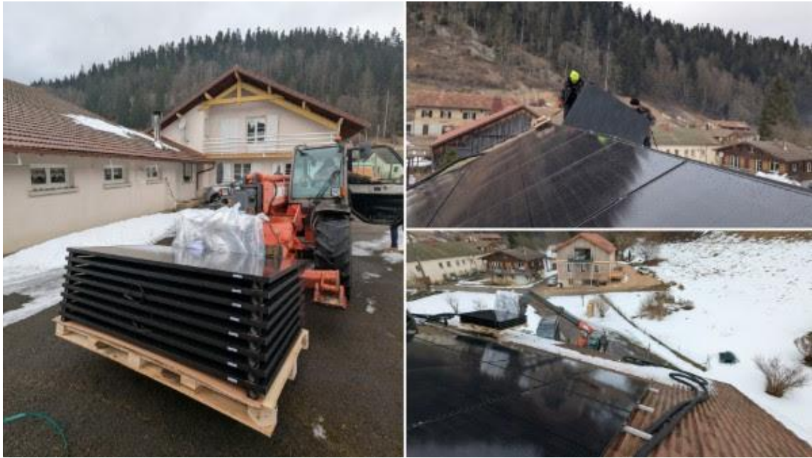
Un chantier Dualsun MAX dans le Doubs en janvier 2026 par l'installateur EcoDoubio
