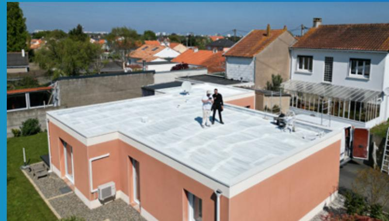
**Réduction de la Température Intérieure** : Les toitures blanches réfléchissent les rayons solaires, diminuant ainsi la température intérieure des bâtiments jusqu'à 4°C, ce qui augmente le confort sans recourir excessivement à la climatisation.
