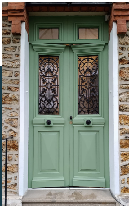
Après - La porte est isolée et repeinte.
