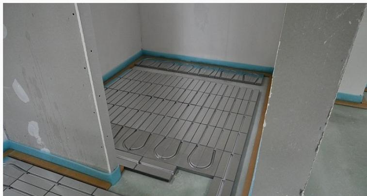
Avec leur faible épaisseur, ces planchers chauffants secs permettent de gagner de précieux millimètres. Très simples à installer, ils sont fournis avec un plan de calepinage + des guides destinés aux installateurs professionnels, mais aussi à tous ceux souhaitant réaliser leurs travaux eux-mêmes.
