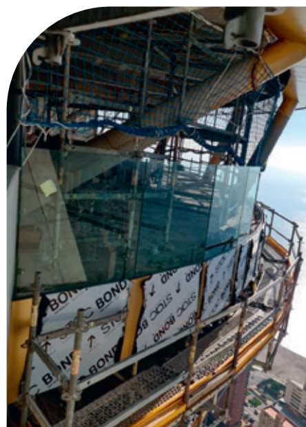
Un chantier aux portes du ciel : Garde-corps GlassFit SV-1802
