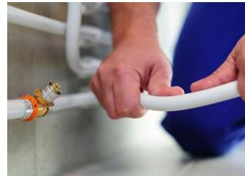
Aujourd'hui, Cochebat tire la sonnette d'alarme : **le "mix & match" – mélange entre tubes et raccords multicouche de gammes différentes - compromet la fiabilité, la sécurité et la durabilité des installations. Les certifications et autres preuves de qualité délivrées dans ce domaine sont toujours attribuées à des ensembles tubes et raccords de même marque et de même gamme.**
