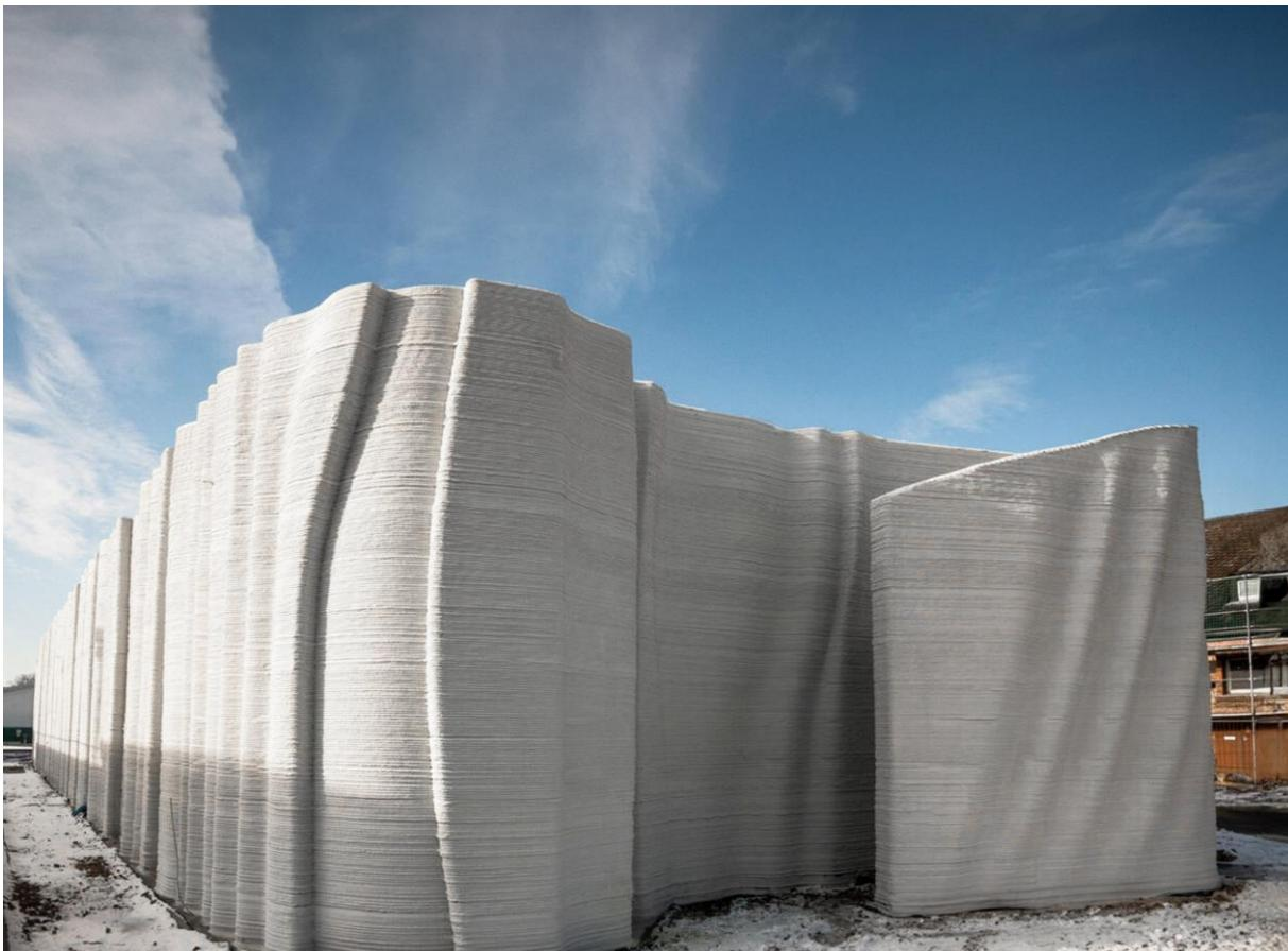
Façade à murs ondulés du plus grand bâtiment imprimé en 3D d'Europe, dont la réalisation aurait été quasiment impossible avec les méthodes de construction traditionnelles.
