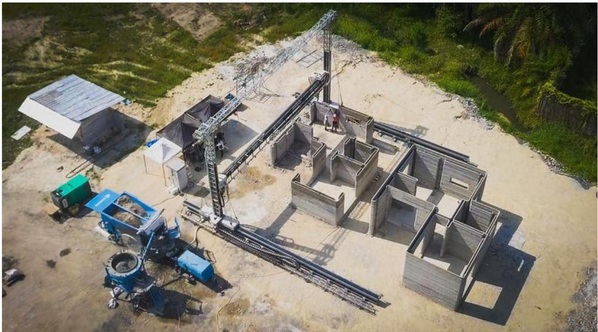
Imprimante de Construction BOD3 avec Système de Livraison de Matériau sur Site en Indonésie.
