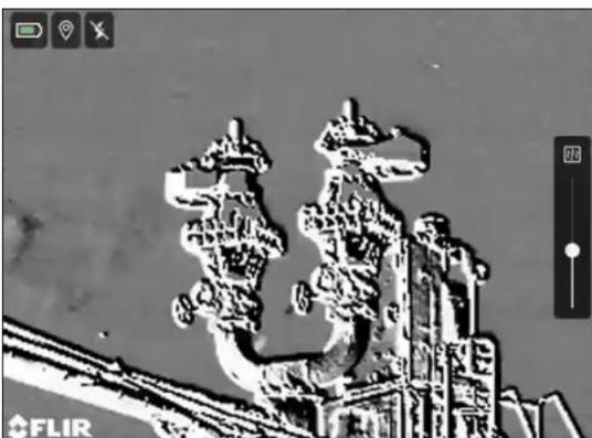
*Les pompes à digestat, comme celle visible dans cette vidéo d'imagerie optique des gaz, acheminent les biomatériaux vers des digesteurs anaérobies. Le matériau étant en fermentation, le risque de fuite de méthane est élevé. Visualisation réalisée à l'aide d'une [FLIR Gx320](#) avec son mode haute sensibilité breveté FLIR activé.*
